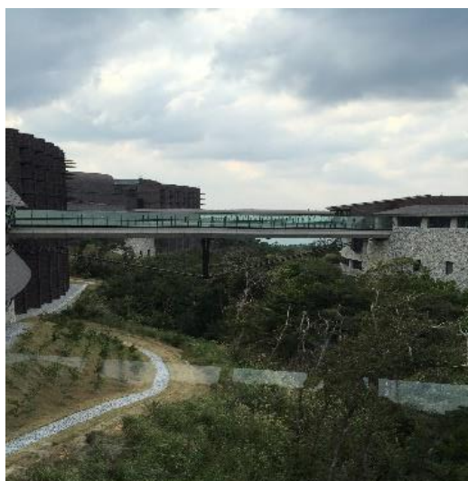
研究棟への橋の上から撮影
